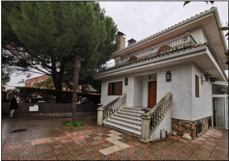
Construcción del nº 30 de la Avenida de Castilla.
