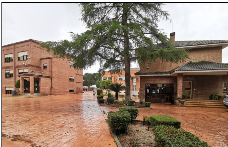
Edificio del Colegio (izquierda) y construcción del nº 32 de la Avenida de Castilla (derecha).
