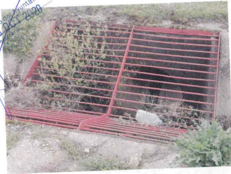
Figura 5. Drenaje transversal al este del ámbito de actuación
