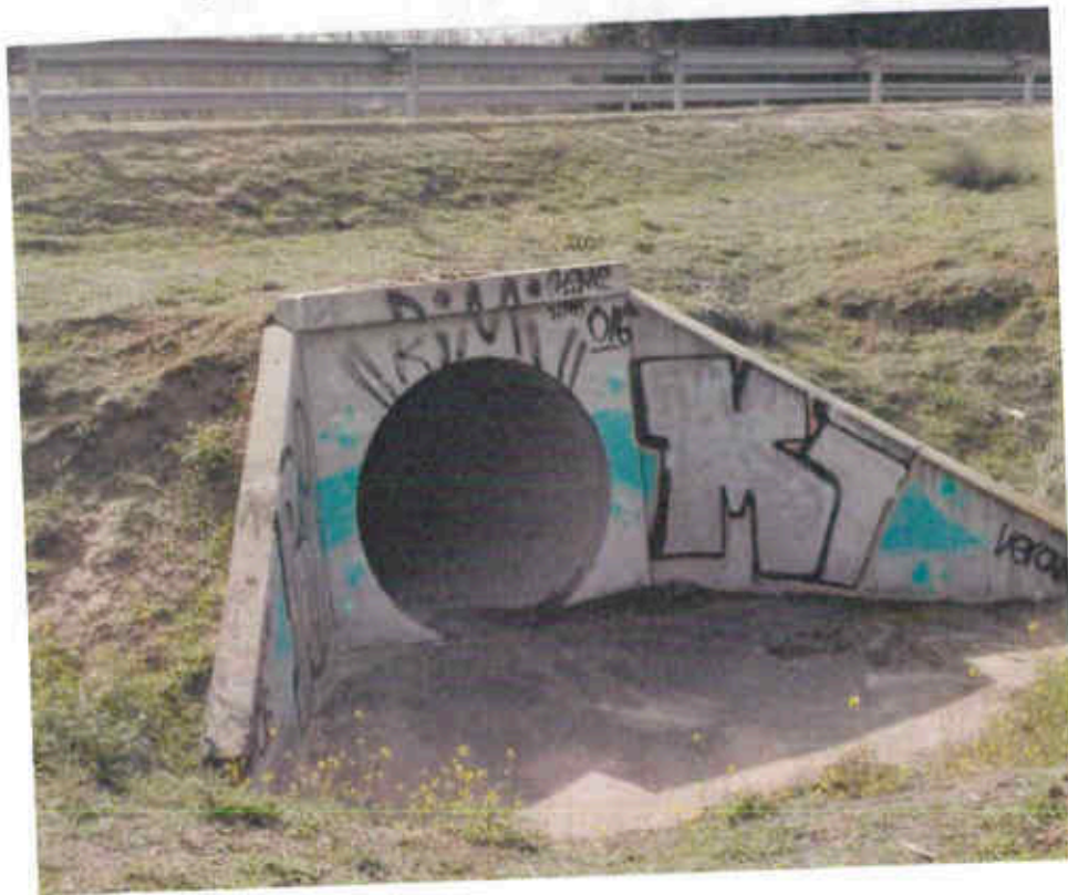
Figura 6. Drenaje transversal situado al oeste del ámbito de actuación
