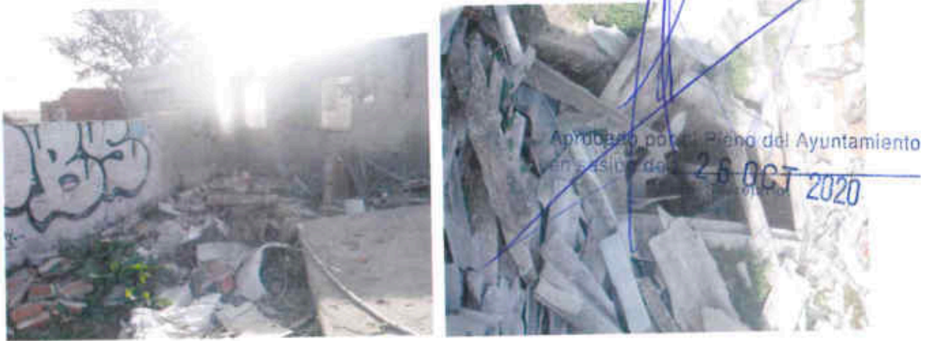
Figura 21. Nave abandonada (detalles)
