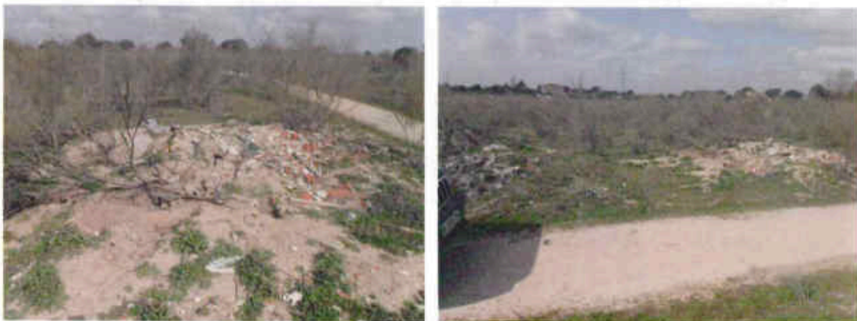
Figura 37. Zona con escombros al N del ámbito
