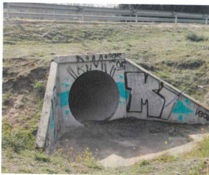
Figura 24. (Izquierda) Drenaje transversal situado al oeste del ámbito de actuación
