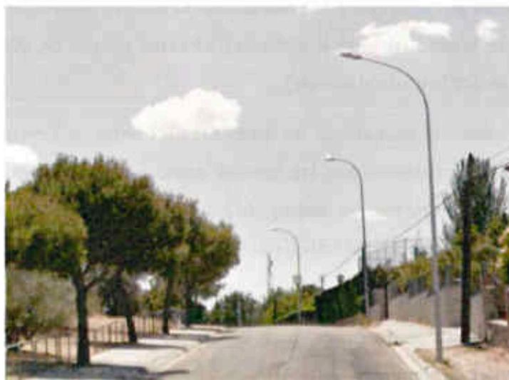
Figura 42. Luminarias en la urbanización el Bosque (calle Miño)
