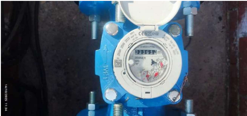
Ilustración 19. Captación n.º 11. Contador CHT.
