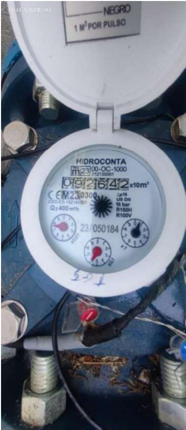
Ilustración 12. Captación n.º 2. Contador CARD.
