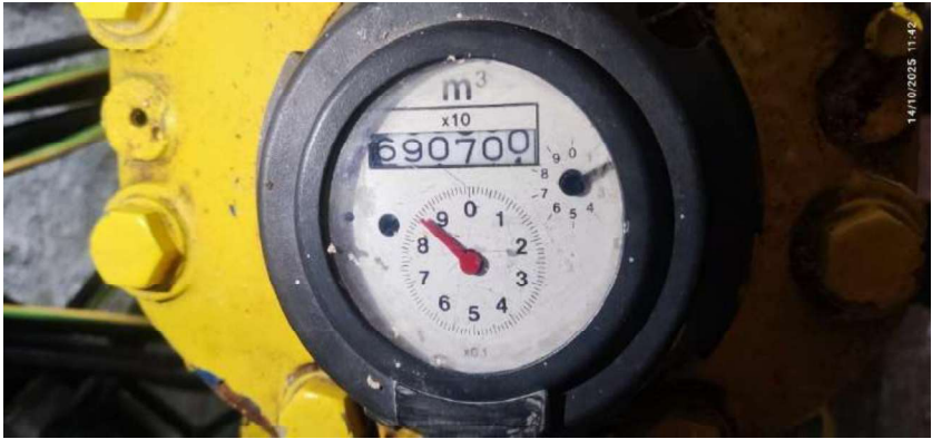
Ilustración 13. Captación n.º 3. Contador CHT.
