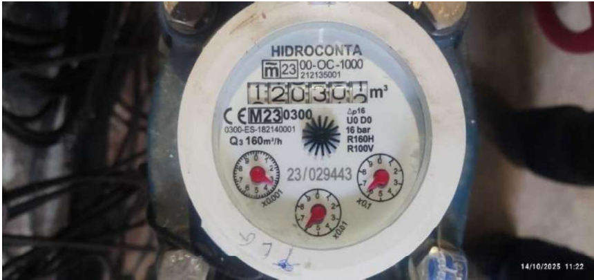
Ilustración 16. Captación n.º 4. Contador CARD.
