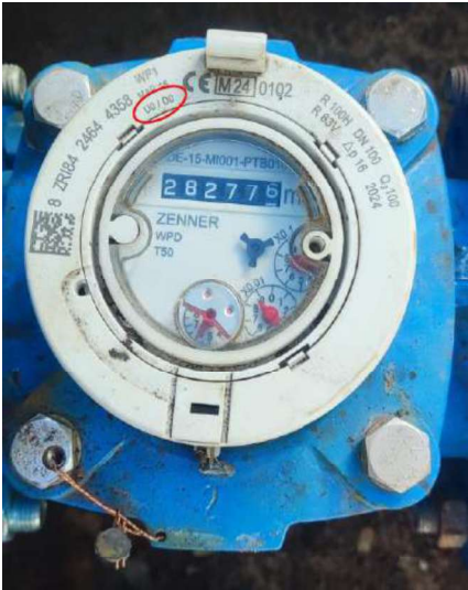
Ilustración 6. Captación n.º 1. Contador CHT. Certificado U0/D0.
