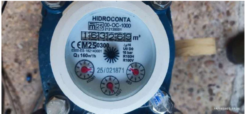
Ilustración 20. Captación n.º 11. Contador CARD.
