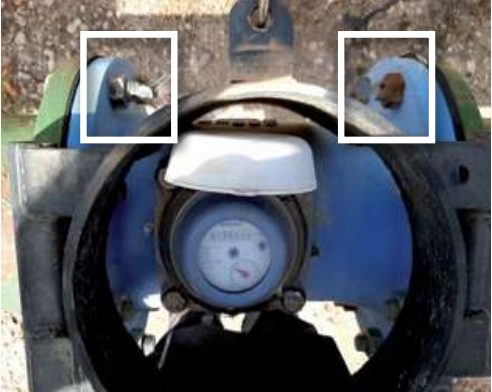
Precinto en los dos lados del contador
