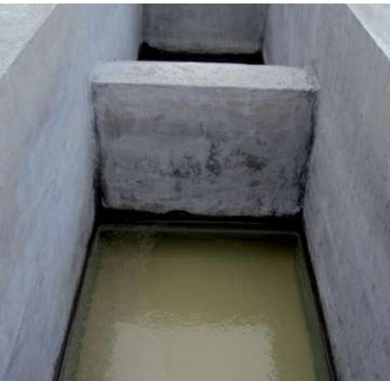
Arqueta de degasificación a salida del pozo
