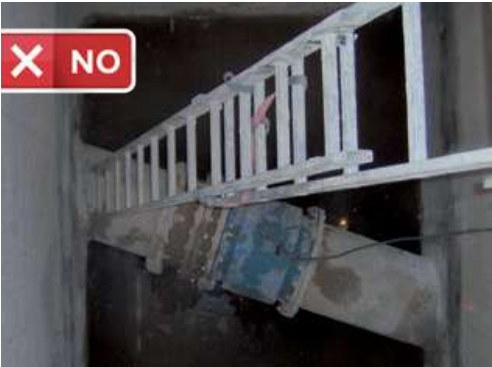
Contador en arqueta de difícil acceso
