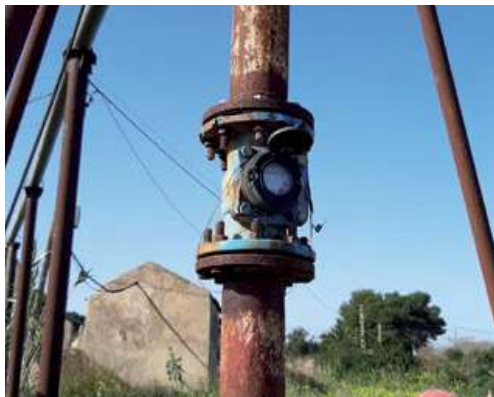
Contador en tramo vertical
