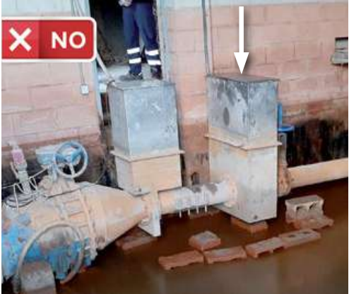
Contador en zona de difícil acceso
