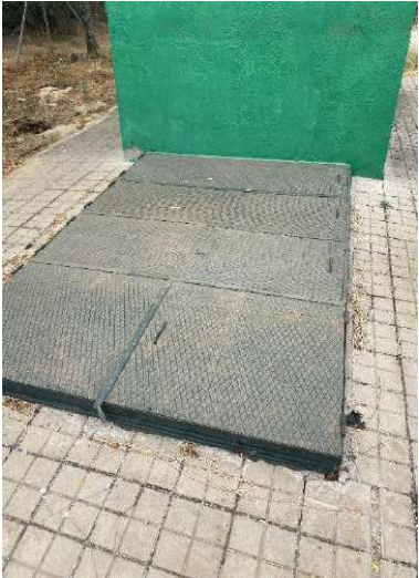
Fotografías 54 y 55 – Estado actual del Pozo Nº15 (desmantelado)
