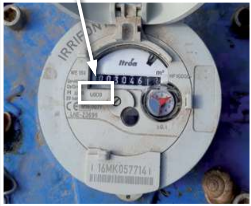
C.V U0D0: No precisa tramos rectos de conducción aguas arriba y abajo del C.V.
