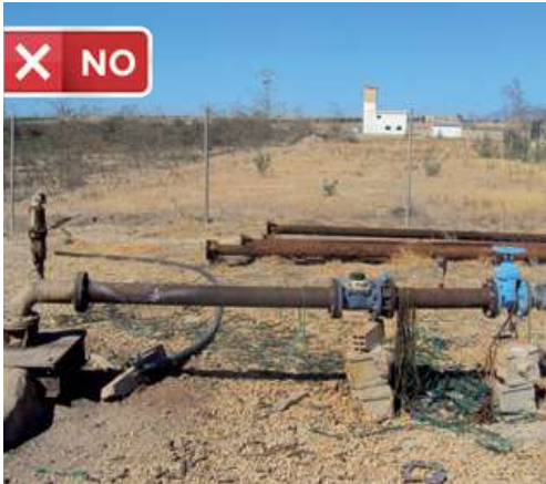
Válvula de retención pegada a contador. No cumple
