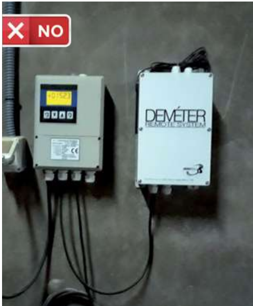
Conexión incorrecta del visor
