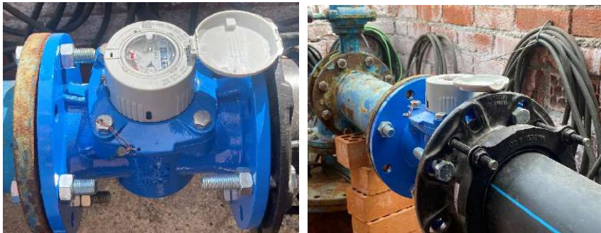
Fotografías 3 y 4. – Detalle del estado de bridas tubería y tramo portante del contador de CHT
