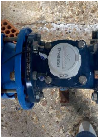
Fotografías 21 y 22 – Detalle abrazadera metálica colocada a ambos lados del contador CARD con sonda (Captura Video IMG_6858)
