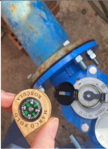
Fig. 7.- Contador de CHT (Principal de cabecera) con inestabilidad de brújula en alrededores o apoyado en ella.
