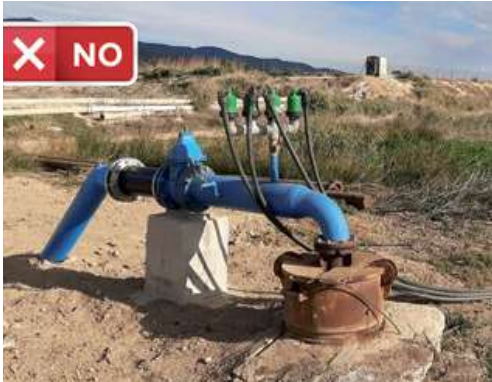
Derivaciones anteriores a contador
