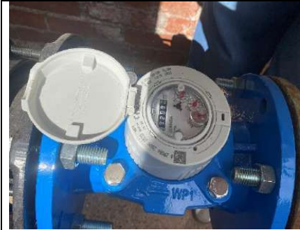
Fig. 5 y 6.- Contador de CHT (Principal de cabecera) sin preclito oficial de Confederación Hidrográfica del Tago (CHT).
