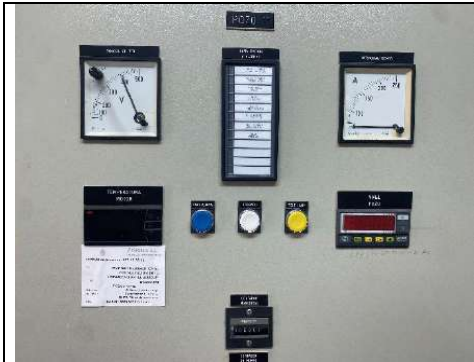
Fig.20.- Cuadro eléctrico de control del Pozo Nº11
