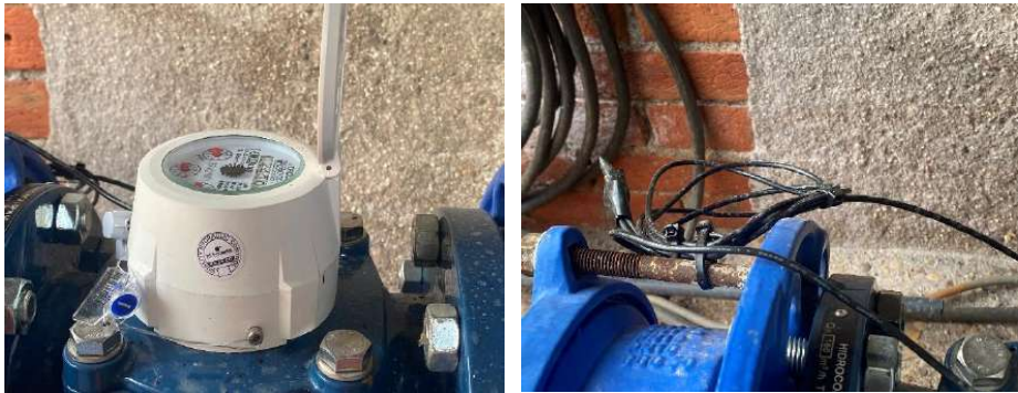
Fotografía 7 y 8. – Detalle del contador CARD con precinto de industria y sonda manipulada.
