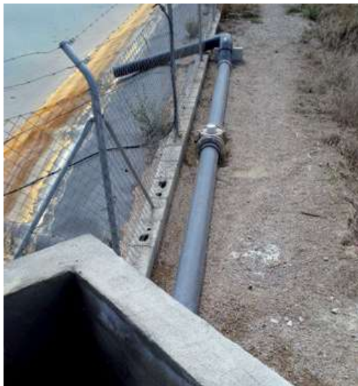
Arqueta de degasificación a salida del pozo
