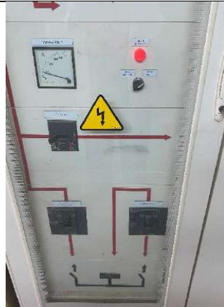
Fig. 65.- Cuadro eléctrico de control con variador de frecuencia. Refiere Pozo N°4, EDAR, etc.
