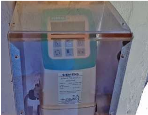
Visor de C.V. electromagnético dentro de armario
