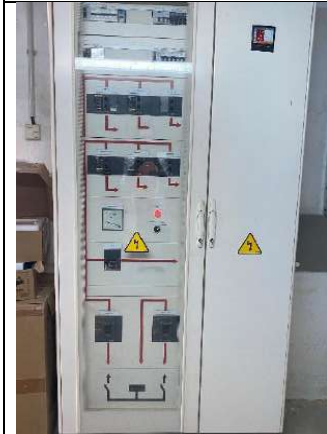
Fig. 64.- Cuadro eléctrico de control con variador de frecuencia. Refiere Pozo N°4, EDAR, etc.
