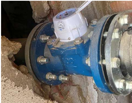
Fotografías 36 y 37 – Detalle de los contadores CARD y CHT del Pozo N°5 (primero y segundo en la línea s/ sentido del agua, respectivamente)
