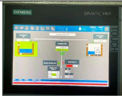
Fig. 63.- Detalle del Sinóptico del Pozo N°5 (SCADA).
