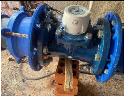
Fig. 5 y 6.- Contador de CHT (Principal de cabecera) sin preclito oficial de Confederación Hidrográfica del Tago (CHT).
