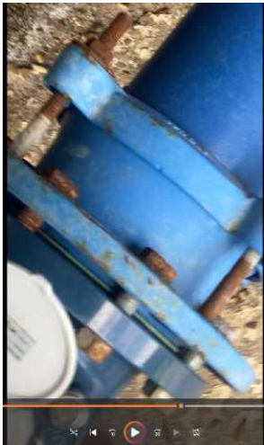
Fotografías 21 y 22 – Detalle abrazadera metálica colocada a ambos lados del contador CARD con sonda (Captura Video IMG_6858)
