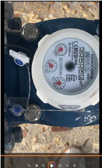
Fotografía 20 –Detalle del Contador CARD precintos de fabricante e Industria. (Captura Vídeo IMG_6855)
