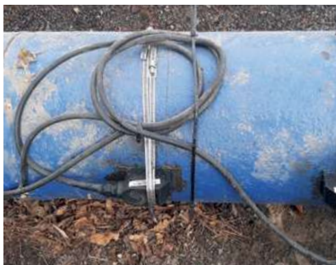
C.V. Ultrasónico fijo en instalación
