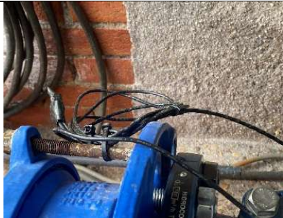
Fig. 11.- Detalle de la sonda del contador CARD con empalme oculto.
