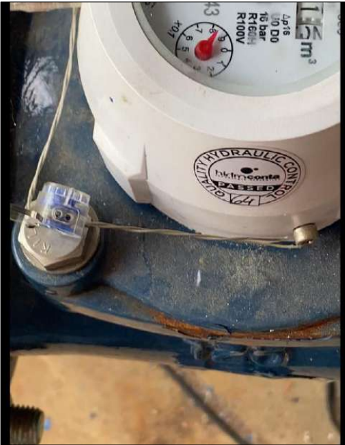
Fotografia 52 – Zoom del contador CARD del Pozo Nº4. Detalle de óxido.
