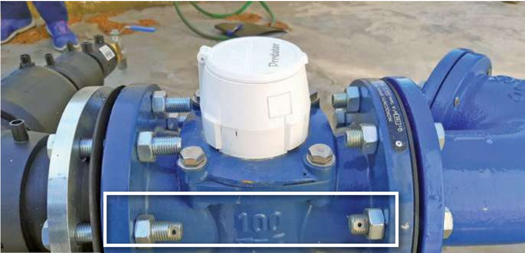
Contador preparado para precintar
