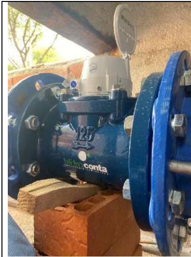
Fig. 9.- Vista lateral contador de CARD, con precintos NO oficiales de Confederación Hidrográfica del Tago.
