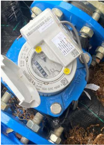
Fotografías 36 y 37 – Detalle de los contadores CARD y CHT del Pozo N°5 (primero y segundo en la línea s/ sentido del agua, respectivamente)
