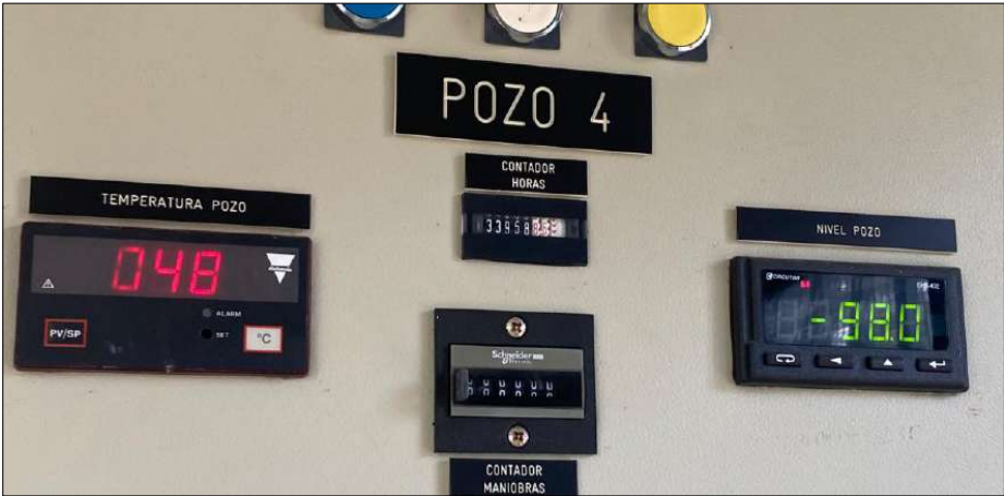
Fotografía 53 – Zoom del cuadro eléctrico del Pozo Nº4. Detalle de marcaje horas y maniobras.
