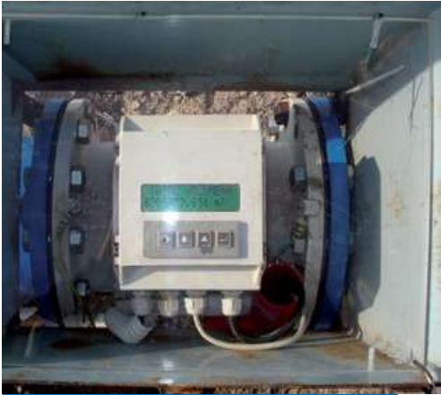
C.V. electromagnético (sensor y visor en carrete de montaje). Placa de metacrilato. No manipulable
