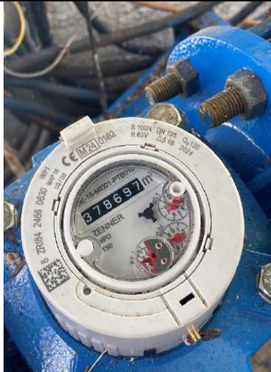
Fig. 51.- Lectura contador de CHT [ZENNER] del Pozo Nº2 (en funcionamiento). Ausencia de módulo de telelectura y sellos ZR según modelo ZENNER (igual en Pozo Nº4 s/ Pozo Nº5)
