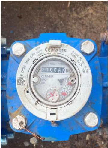
Fotografías 16 y 17 – Detalle de Contadores CHT (Funcional y desmontado) del Pozo Nº1.
