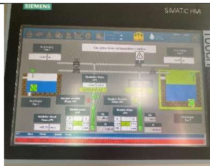
Fig. 41.- Detalle Sinóptico de los Pozos Nº1 y Nº2
