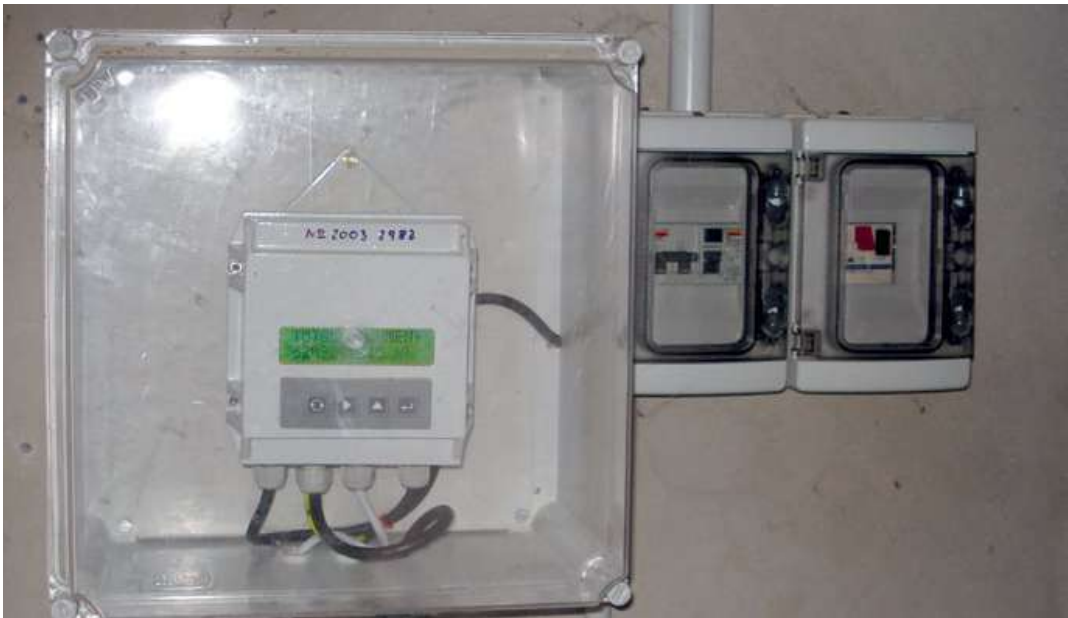
Visor y magnetotérmicos de C.V. en cajas independientes no manipulables
