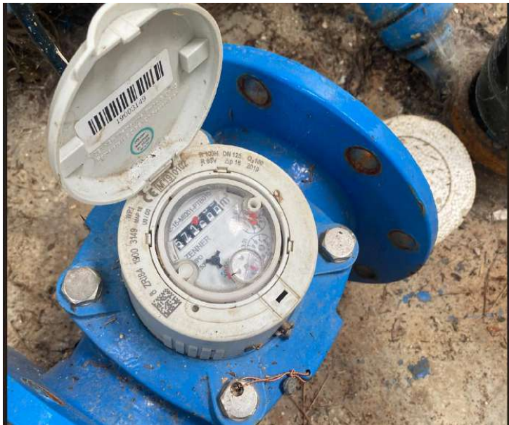
Fotografías 30 – Zoom del contador desmontado del Pozo N°2
