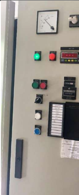
Fig. 53.- Detalle horas de funcionamiento de Bombas y maniobras del Pozo Nº2
