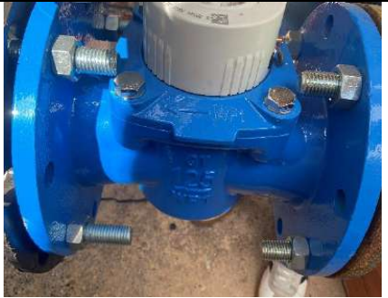
Fig. 5 y 6.- Contador de CHT (Principal de cabecera) sin preclito oficial de Confederación Hidrográfica del Tago (CHT).
