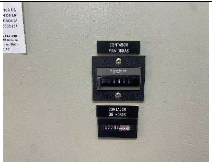
Fig. 21.- Detalle horas de funcionamiento y maniobras Bombas Pozo Nº11
