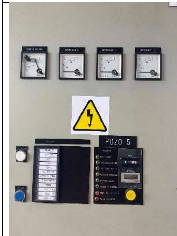
Fig. 66.- Parte del cuadro eléctrico de control del Pz.5.
