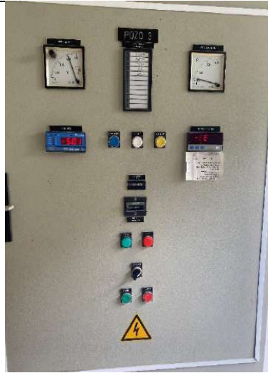
Fig. 76.- Cuadro eléctrico de control del Pozo Nº3
