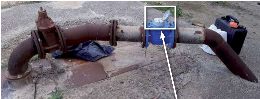
C.V U0D0: No precisa tramos rectos de conducción aguas arriba y abajo del C.V.
