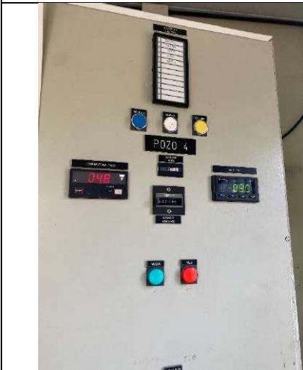
Fig. 84. - Contador CHT [ZENNER] del Pozo Nº4 (primero en cabeza de línea). Presenta precintos de fabricante/instalador sólo.Replintado.
