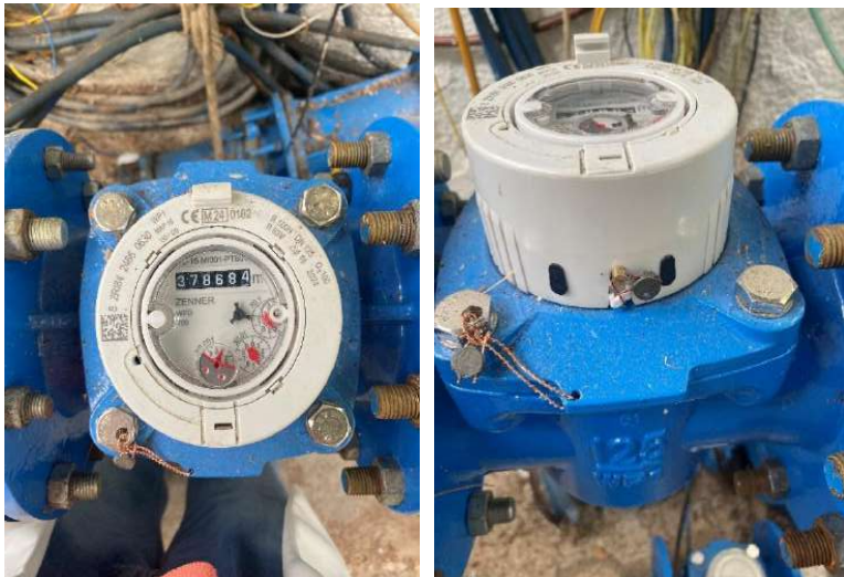
Fotografías 26 y 27 – Detalle del contador de CHT del Pozo Nº2 y sus precintos no oficiales de CHT.
