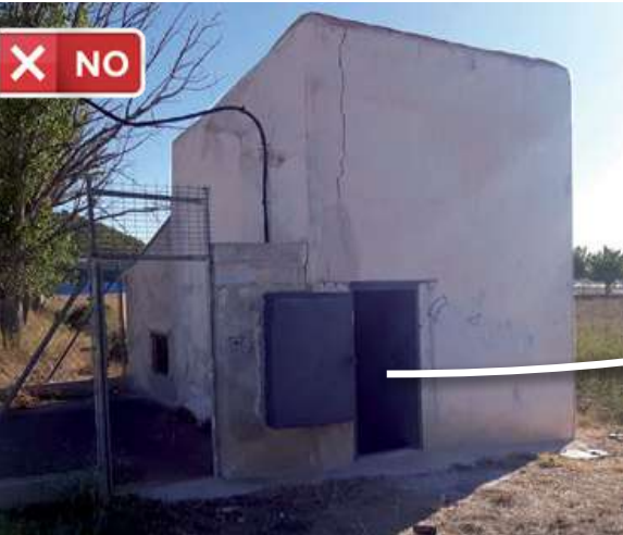
Contador en interior de caseta. No accesible
