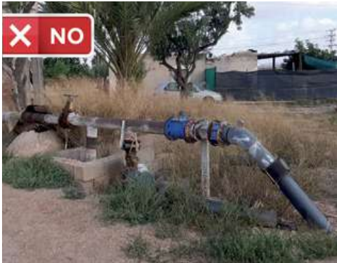
Derivaciones anteriores al contador. No cumple
