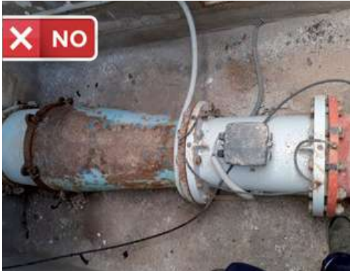
Contador electromagnético junto a reducción de la tubería. No cumple
