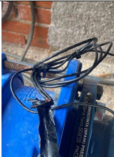
Fig. 14.- Evidencia del corte de cables y emplame al retirar la cinta aislante.
