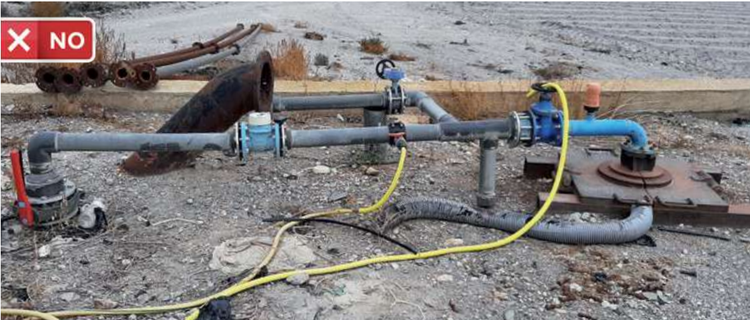
Derivaciones anteriores al contador. No cumple
