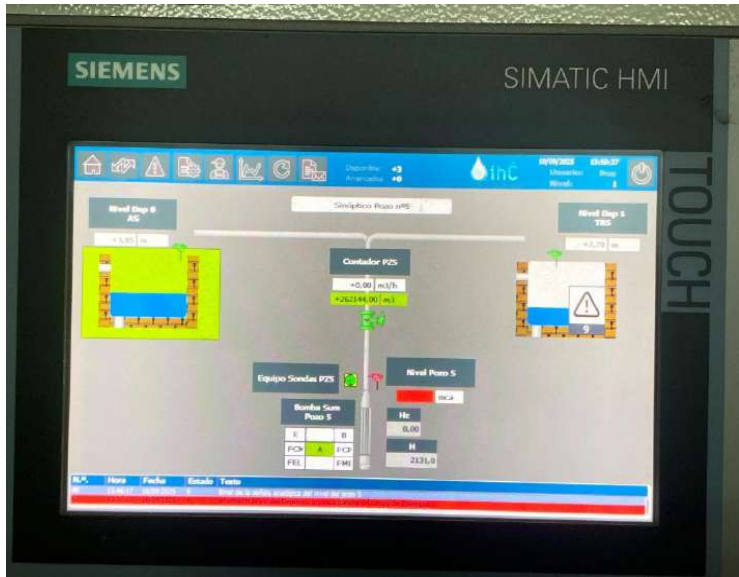
Fotografía 41 – Detalle del SCADA del Pozo N°5
