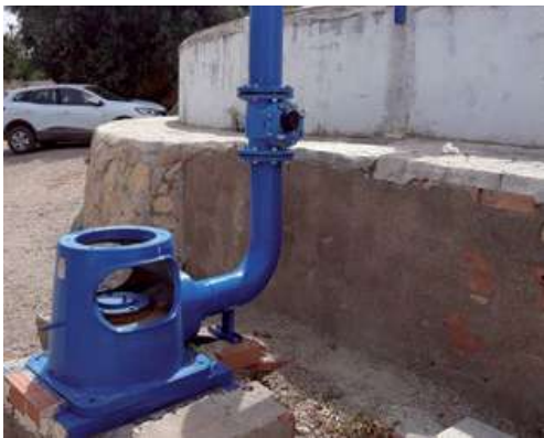
Contador en tramo vertical
