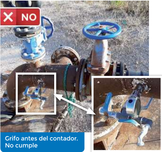
Derivaciones anteriores al contador. No cumple
