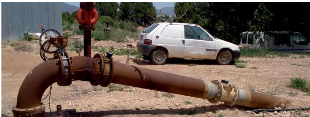
Contador en tramo descendente (válido si la tubería está en carga o existe válvula de retención detrás del C.V.)
