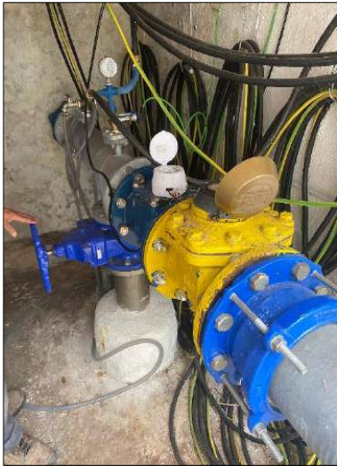
Fotografías 44 y 45 – Detalle de la disposición consecutiva de los contadores del Pozo Nº3
