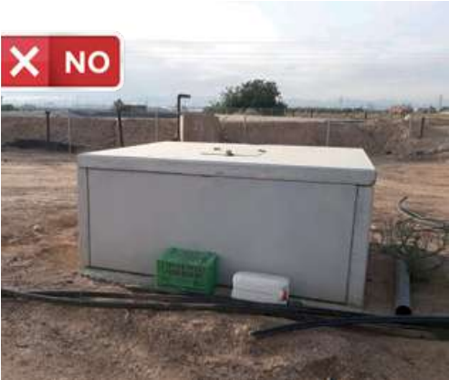
Contador en arqueta inaccesible
