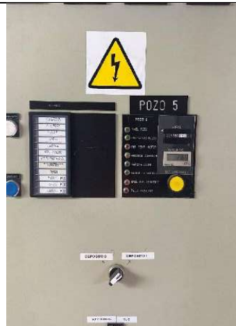
Fig. 67.- Detalle de horas de funcionamiento y maniobras Pz.5
