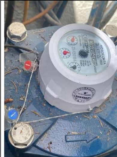
Fig. 50.- Detalle de contador de CARD [HIDROCONTA] del Pozo Nº2. Se observan precintos que no son los oficiales de CHT.
