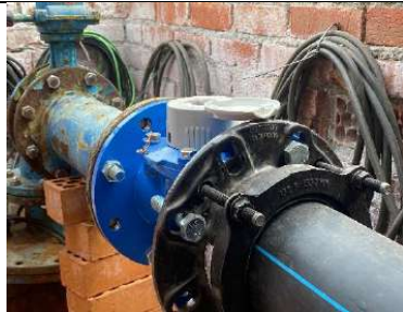
Fig. 10.- Detalle de contador CARD [HIDROCONTA] y sonda sospechosa.
