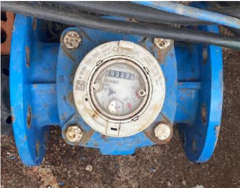
Fotografías 16 y 17 – Detalle de Contadores CHT (Funcional y desmontado) del Pozo Nº1.
