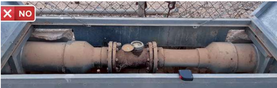
Reducciones junto a contador. No cumple
