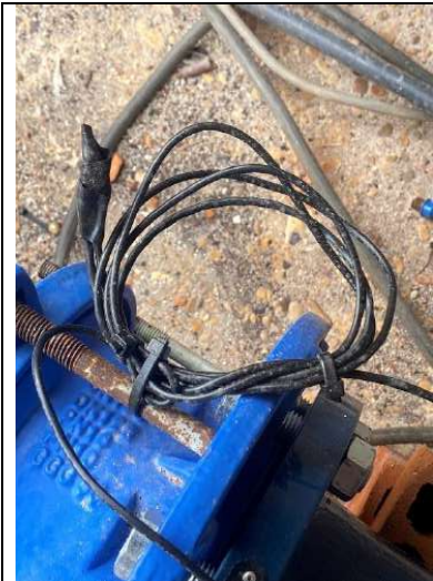
Fig. 13.- Detalle del empalme oculto de la sonda asociada al contador CARD del Pozo Nº11
