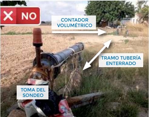
Tramo de tubería enterrado anterior al contador. No cumple
