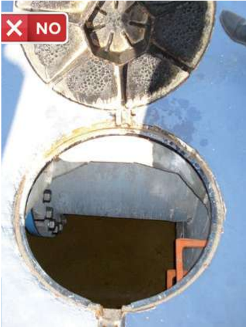
Contador en arqueta de difícil acceso
