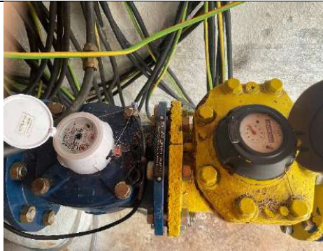
Fig. 73.- Contador de CHI COSMOS-CONTAGUA sin precintos oficiales de Confederación.
