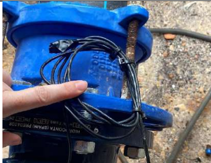
Fig. 13.- Detalle del empalme oculto de la sonda asociada al contador CARD del Pozo Nº11
