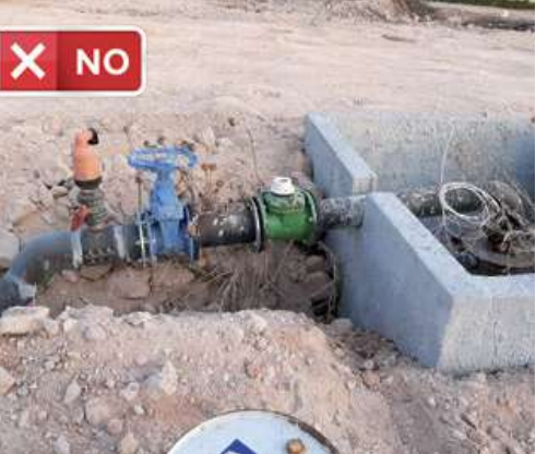
Contador en zona de difícil acceso
