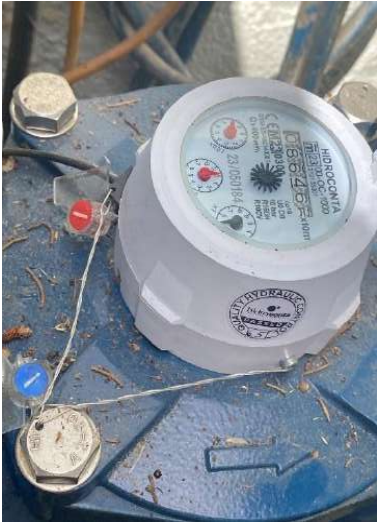
Fotografía 31 – Detalle de lectura del contador CARD del Pozo Nº2 y sus precintos comerciales
